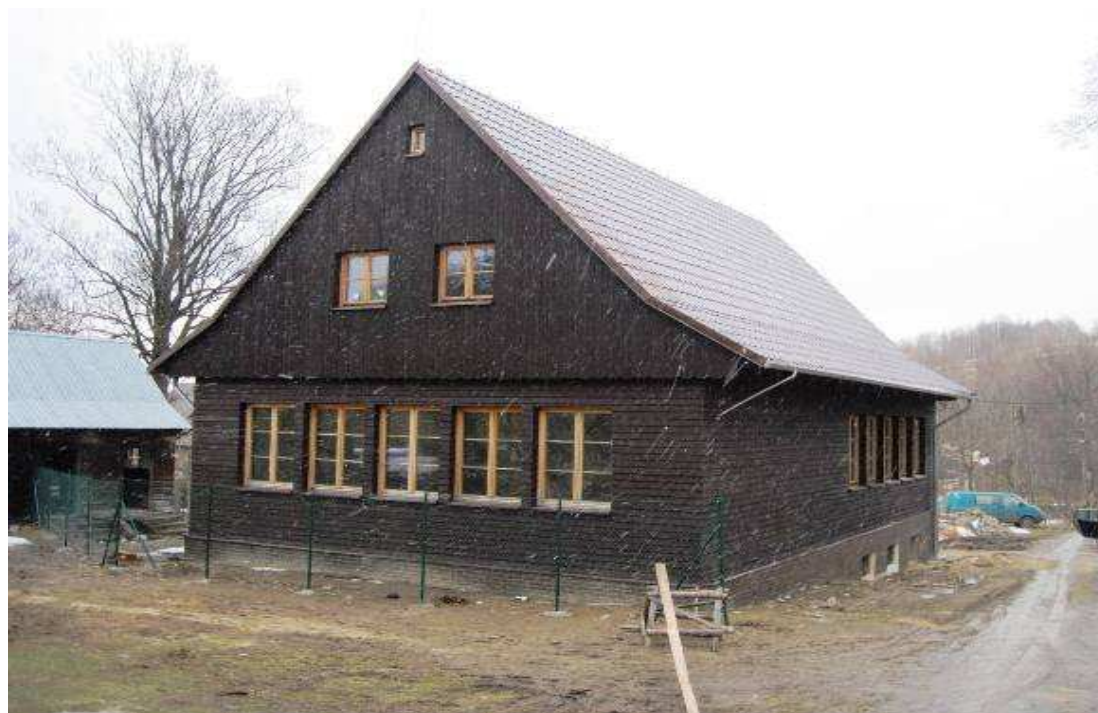
Przecznica. Świetlica wiejska.
